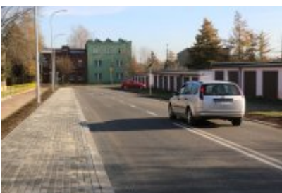
Obwodnica osiedla Piłsudskiego w Czeladzi
