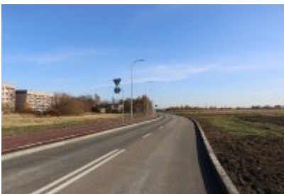
Obwodnica osiedla Piłsudskiego w Czeladzi
