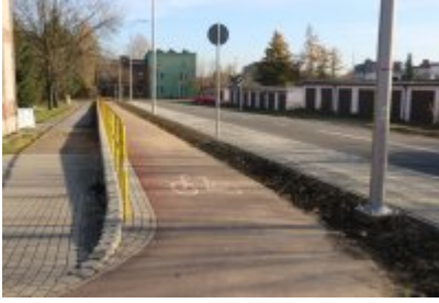
• Obwodnica osiedla Piłsudskiego w Czeladzi
