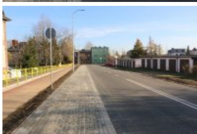
Obwodnica osiedla Piłsudskiego w Czeladzi
