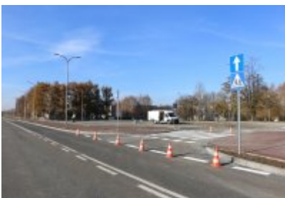
• Obwodnica osiedla Piłsudskiego w Czeladzi
