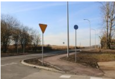
Obwodnica osiedla Piłsudskiego w Czeladzi
