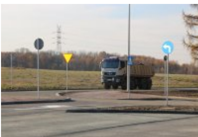
• Obwodnica osiedla Piłsudskiego w Czeladzi
