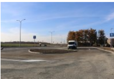
• Obwodnica osiedla Piłsudskiego w Czeladzi
