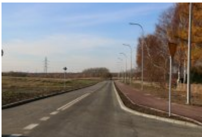
Obwodnica osiedla Piłsudskiego w Czeladzi
