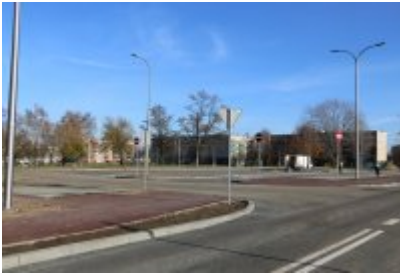
• Obwodnica osiedla Piłsudskiego w Czeladzi
