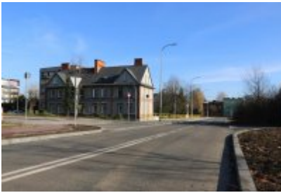
• Obwodnica osiedla Piłsudskiego w Czeladzi
