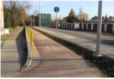
• Obwodnica osiedla Piłsudskiego w Czeladzi
