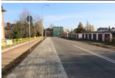
Obwodnica osiedla Piłsudskiego w Czeladzi
