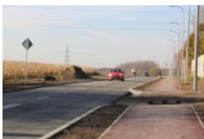
Obwodnica osiedla Piłsudskiego w Czeladzi
