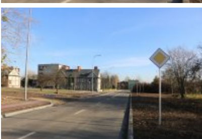
• Obwodnica osiedla Piłsudskiego w Czeladzi
