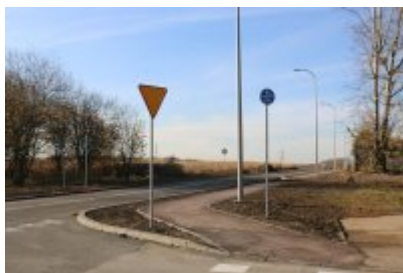
Obwodnica osiedla Piłsudskiego w Czeladzi
