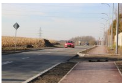
Obwodnica osiedla Piłsudskiego w Czeladzi
