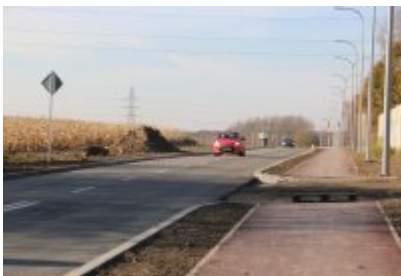
Obwodnica osiedla Piłsudskiego w Czeladzi
