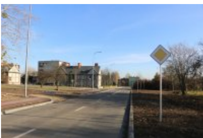
• Obwodnica osiedla Piłsudskiego w Czeladzi
