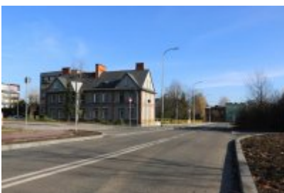
• Obwodnica osiedla Piłsudskiego w Czeladzi
