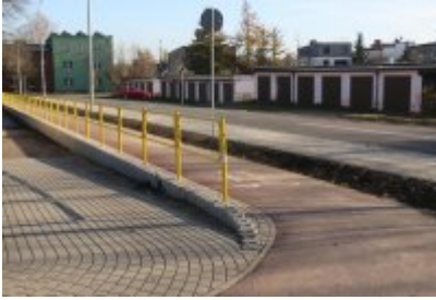
• Obwodnica osiedla Piłsudskiego w Czeladzi
