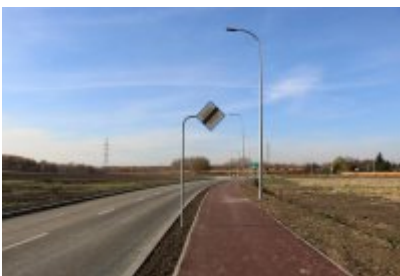
• Obwodnica osiedla Piłsudskiego w Czeladzi
