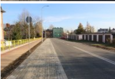
Obwodnica osiedla Piłsudskiego w Czeladzi
