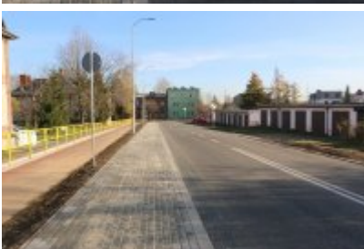
Obwodnica osiedla Piłsudskiego w Czeladzi
