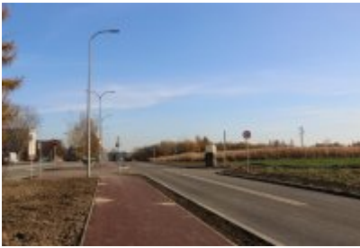
• Obwodnica osiedla Piłsudskiego w Czeladzi
