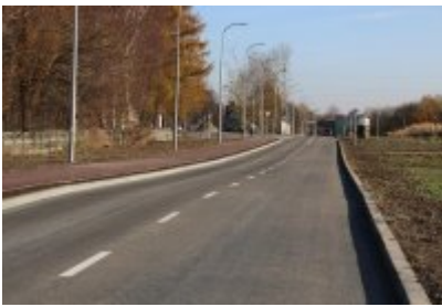
• Obwodnica osiedla Piłsudskiego w Czeladzi
