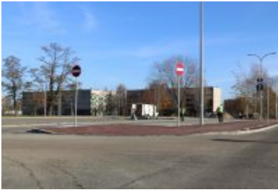
• Obwodnica osiedla Piłsudskiego w Czeladzi
