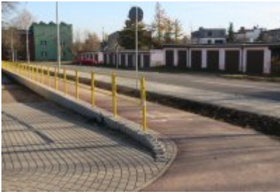
• Obwodnica osiedla Piłsudskiego w Czeladzi
