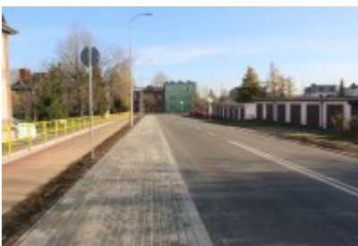
Obwodnica osiedla Piłsudskiego w Czeladzi
