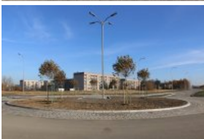
• Obwodnica osiedla Piłsudskiego w Czeladzi
