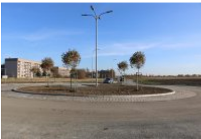
• Obwodnica osiedla Piłsudskiego w Czeladzi
