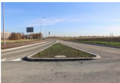
• Obwodnica osiedla Piłsudskiego w Czeladzi
