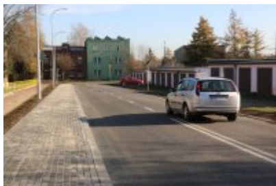
Obwodnica osiedla Piłsudskiego w Czeladzi
