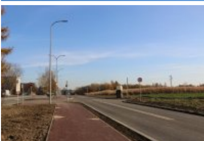
• Obwodnica osiedla Piłsudskiego w Czeladzi
