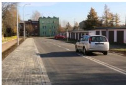
Obwodnica osiedla Piłsudskiego w Czeladzi
