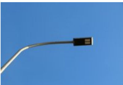
• Obwodnica osiedla Piłsudskiego w Czeladzi
