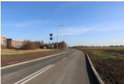
Obwodnica osiedla Piłsudskiego w Czeladzi
