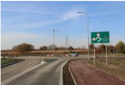
Obwodnica osiedla Piłsudskiego w Czeladzi
