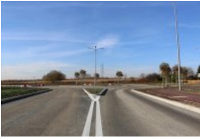
• Obwodnica osiedla Piłsudskiego w Czeladzi
