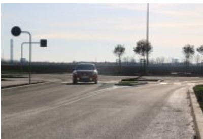
• Obwodnica osiedla Piłsudskiego w Czeladzi
