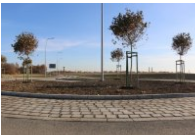
• Obwodnica osiedla Piłsudskiego w Czeladzi
