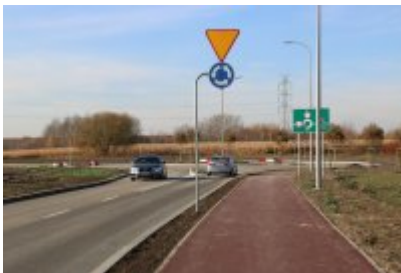
Obwodnica osiedla Piłsudskiego w Czeladzi
