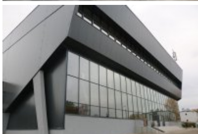
Hala sportowa po termomodernizacji
