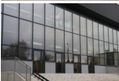
Hala sportowa po termomodernizacji
