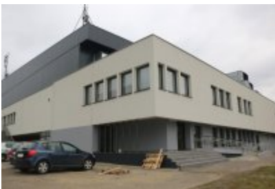
Hala sportowa po termomodernizacji
