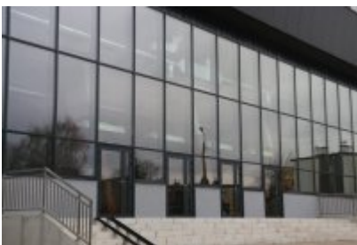
• Hala sportowa po termomodernizacji
