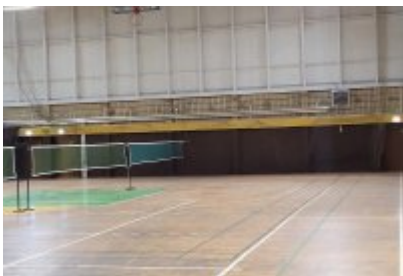
• Hala sportowa po termomodernizacji
