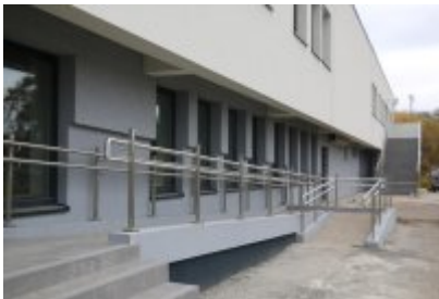
• Hala sportowa po termomodernizacji
