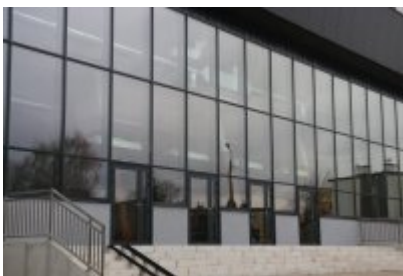
• Hala sportowa po termomodernizacji
