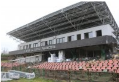
Hala sportowa po termomodernizacji
