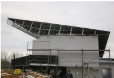
Hala sportowa po termomodernizacji
