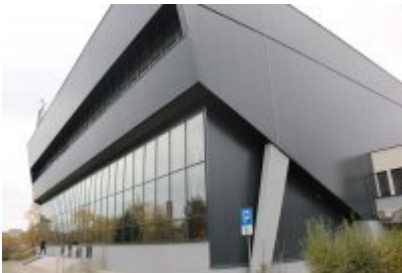
• Hala sportowa po termomodernizacji
