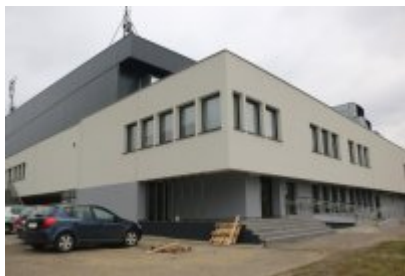
Hala sportowa po termomodernizacji
