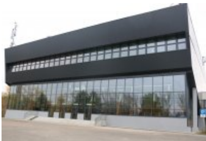
• Hala sportowa po termomodernizacji
