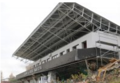
Hala sportowa po termomodernizacji
