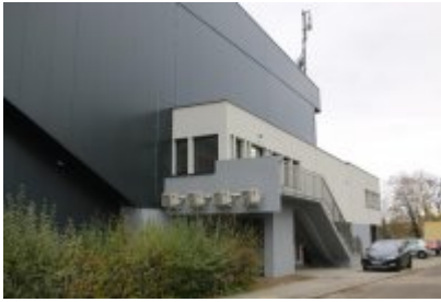
• Hala sportowa po termomodernizacji
