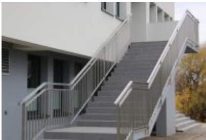
• Hala sportowa po termomodernizacji
