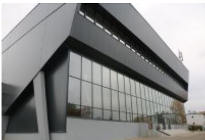
• Hala sportowa po termomodernizacji
