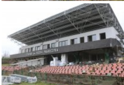
Hala sportowa po termomodernizacji
