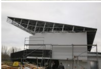
Hala sportowa po termomodernizacji
