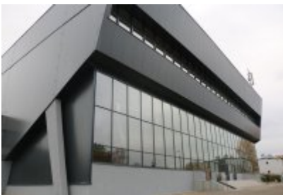
• Hala sportowa po termomodernizacji
