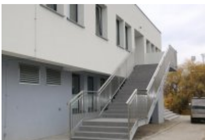
• Hala sportowa po termomodernizacji
