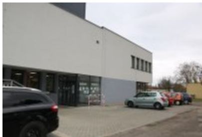
Hala sportowa po termomodernizacji
