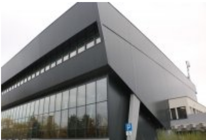
• Hala sportowa po termomodernizacji
