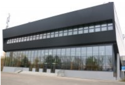
• Hala sportowa po termomodernizacji
