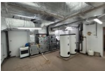
• Hala sportowa po termomodernizacji
