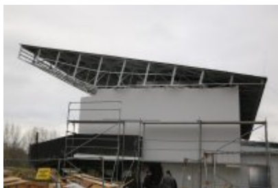
Hala sportowa po termomodernizacji
